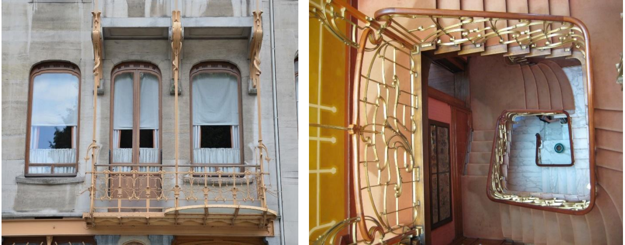
Figura 18. A la izquierda, detalle del balcón. A la derecha, detalle de la escalera principal. Fuente: sitio web de Horta Museum .
