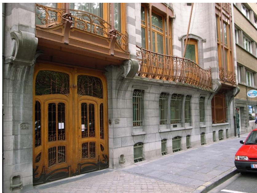
Figura 16. Detalle de fachada de la propiedad. Fuente: fotos de Google.
