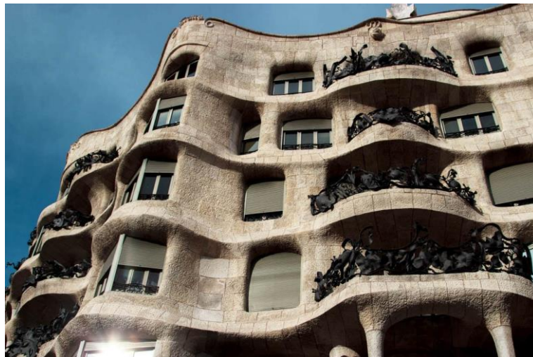
Figura 21. Arriba, detalle de ventanal de Casa Batlló. Abajo, La Pedrera (Casa Milà). Fuente: https://www.casabatllo.es/
